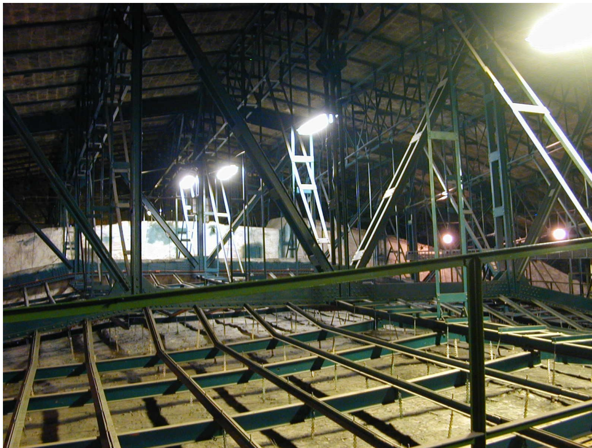
Rabicboltozatot tartó összetett szerkezet.
