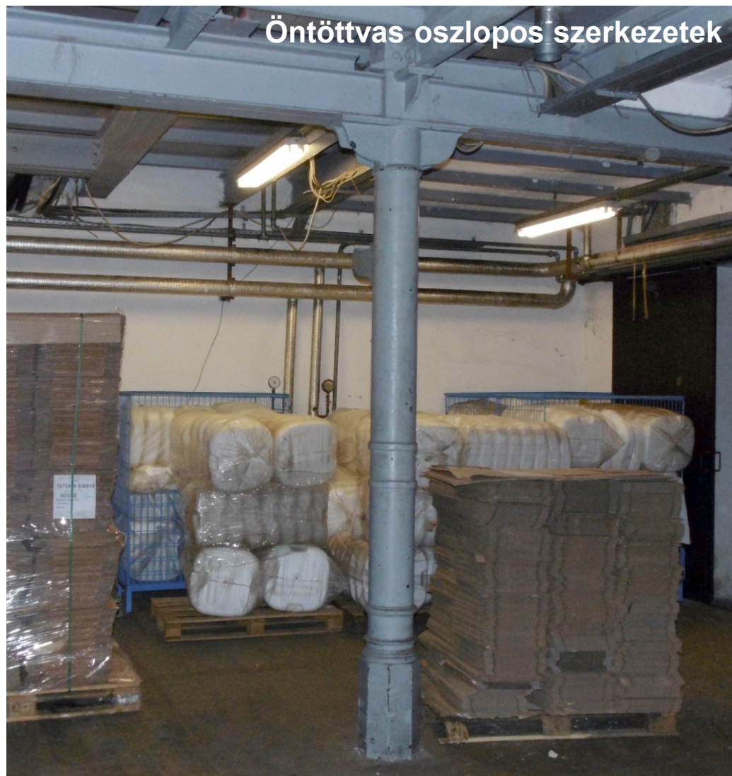
Öntöttvas oszlopos, gerendás szerkezet.
