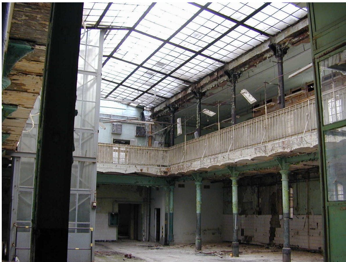
Lakóházba beépített öntöttvas gerendás szerkezet.
