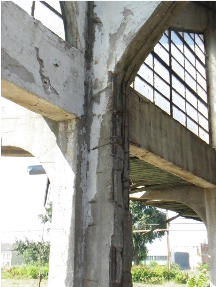
Kétcsuklós tartós vasbeton szerkezet.
