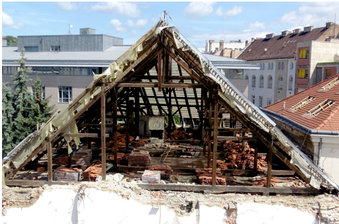
Ötszelemenes fedélszék.
