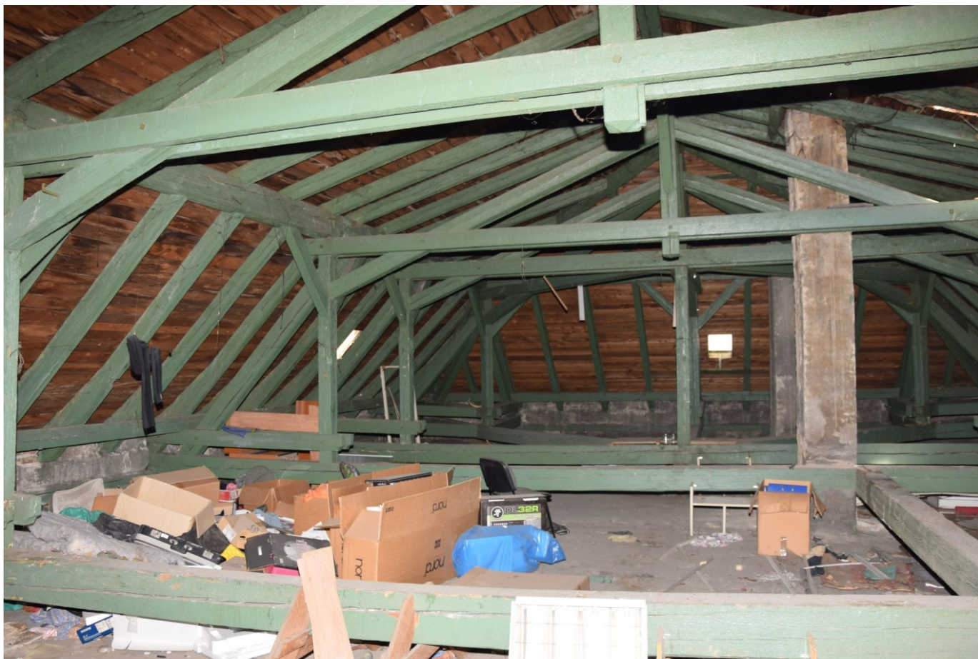
Állószékes szerkezetből levezetett manzárdos fedés.
