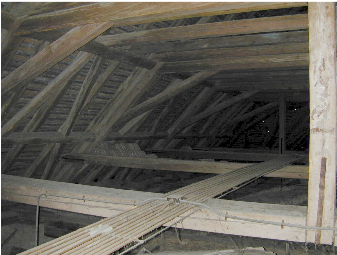
Kitámasztott feszítőbordás fedélszék.
